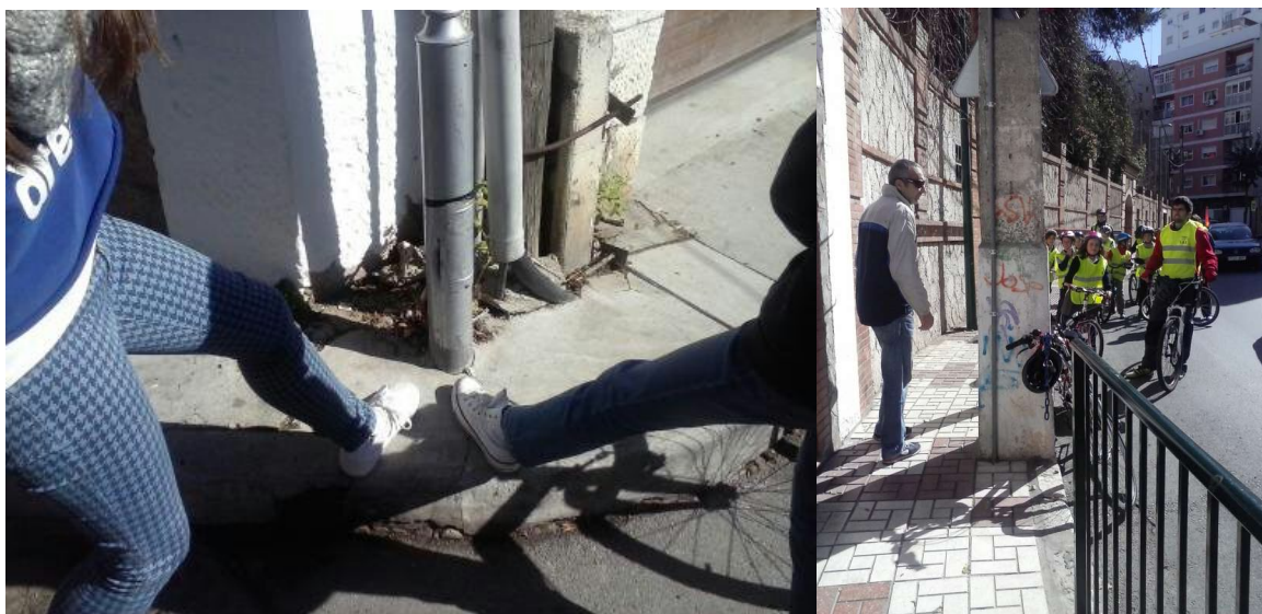
Ejemplos de incidencias detectadas en el curso de las pruebas de caminos escolares en Málaga (aceras estrechas y barreras arquitectónicas).
